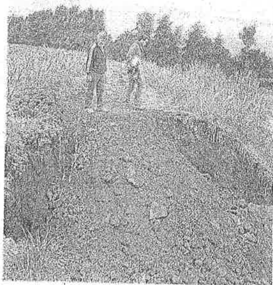
LA SCOPERTA Un'altra frana dopo la bomba d'acqua: ha ceduto l'argine della Nievole nel Padule di Fucecchio
